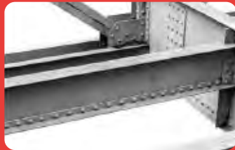
Vigas y Columnas
