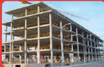
Estructura de Hormigon
