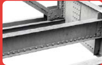
Vigas y Columnas
