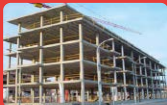
Estructura de Hormigon
