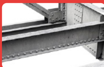
Vigas y Columnas
