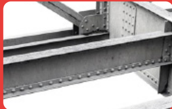
Vigas y Columnas
